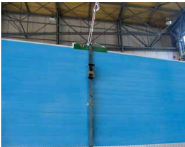
Рис. 9. Применение специализированного монтажного инструмента для размещения сэндвич-панелей в горизонтальном положении.
