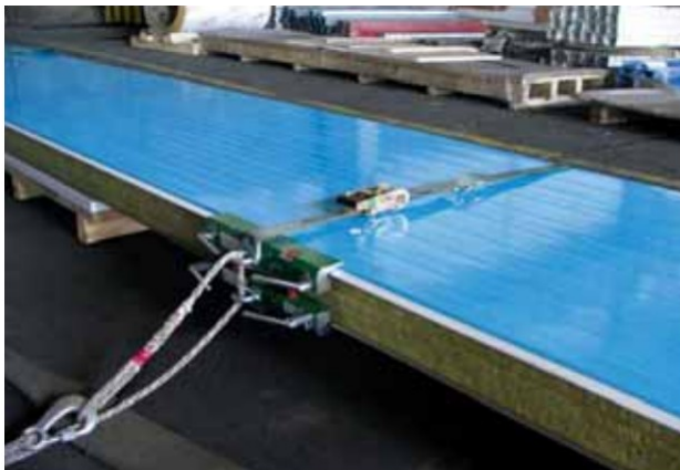
Рис. 3. Монтажный подъемный инструмент для панелей ТПК Веста при размещении в вертикальном состоянии.
