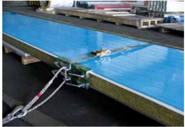
Рис. 15. Подъемный монтажный инструмент для сэндвич-панелей при размещении в вертикальном положении.
