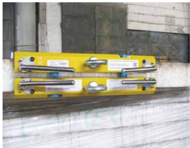
Рис. 10. Применение специализированного монтажного инструмента для размещения сэндвич-панелей в вертикальном положении.
